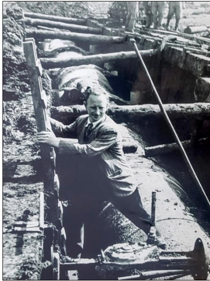
Izaak Verhoek bij de aanleg van 'zijn' waterleiding.
