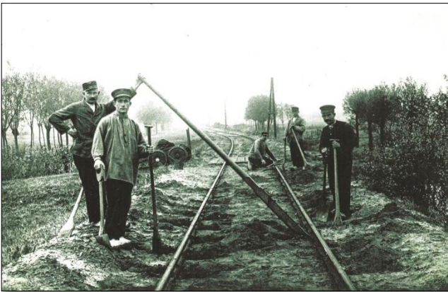
Met de schop en een handhefboom rails leggen.
