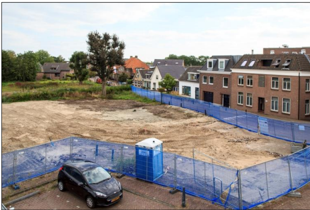
Het braakliggend terrein aan de Burg. Uilkenstraat
